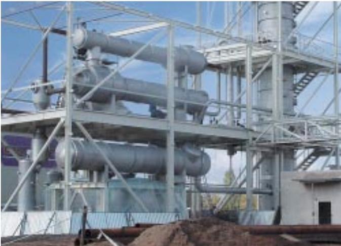
1-stufige Destillationsanlage zur Ethanolgewinnung, während der Montage
