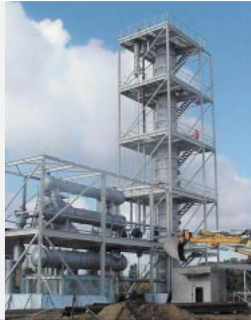
Hier ist besonders gut die Anordnung des Zwangsumlaufverdampfers unterhalb des Kondensators bzw. des Vorwärmers zu erkennen. Mit dieser Anlage wird aus fermentiertem stärkehaltigem Abwasser Ethanol gewonnen. Die vorgeschaltete
