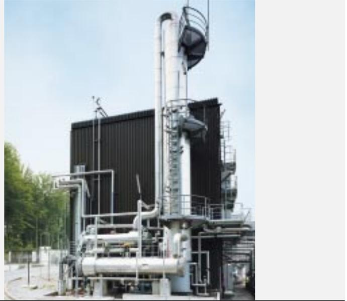
Zur Schonung der Umwelt und zur Reduzierung von Betriebsmittel- und Entsorgungskosten werden Lösungs- und Fällungsmittel aus Prozess- und Abwässern von Extraktionsanlagen zurückgewonnen, aufbereitet und in hoher Reinheit dem Extraktionsprozess wieder zugeführt. In diesen Anwendungsbereichen ist die Zahl der zu behandelnden Lösungsmittel sehr groß und das Leistungsspektrum der Anlagen besonders umfangreich.
