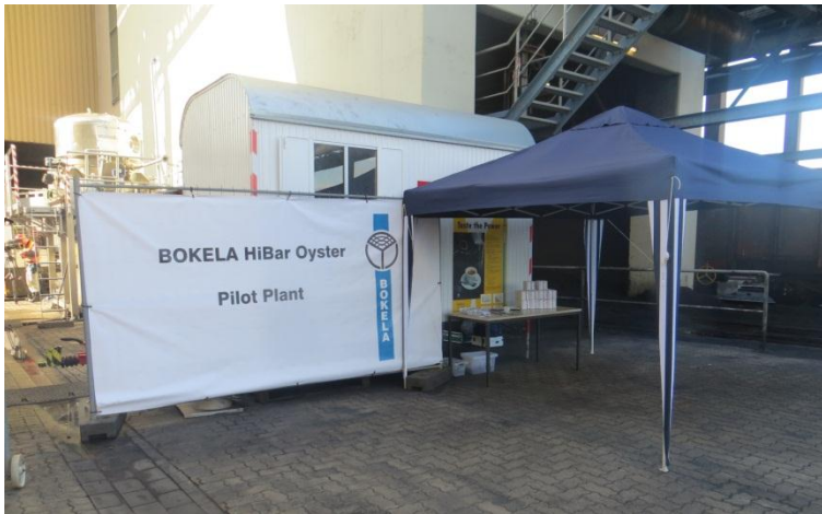
BOKELA HiBar Pilotanlage Aufstellungsort im Bergwerk Auguste Victoria (RAG)
